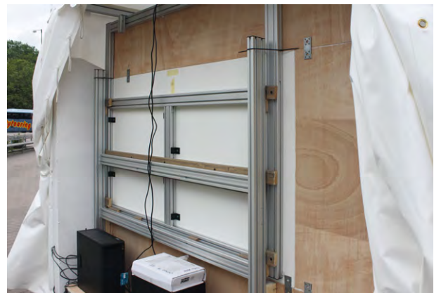
Bild 23: Konstruktion der mobilen Multimediawand
